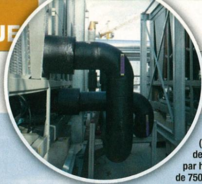
La production d'eau glacée (8/14°C) nécessaire aux besoins de climatisation est assurée par huit et à terme seize groupes froid de 750 kW à condensation par air.
