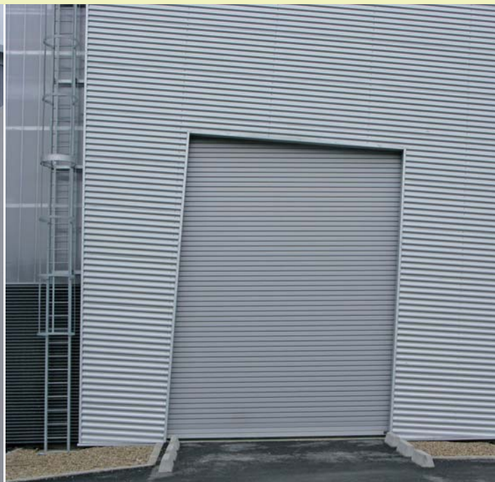
↑ Cette ouverture inclinée mène en fait à une porte-rideau parfaitement droite. Le biais a été calculé pour laisser un passage de 6 mètres de haut.
